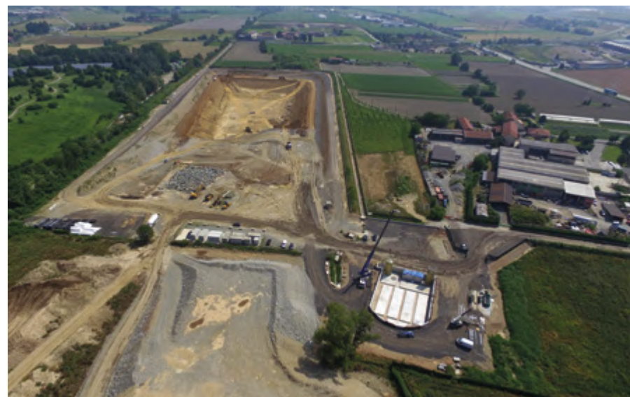
I lavori di costruzione del nuovo impianto Barricalla 2 a Collegno (To); sopra, Alessandro Battaglini
